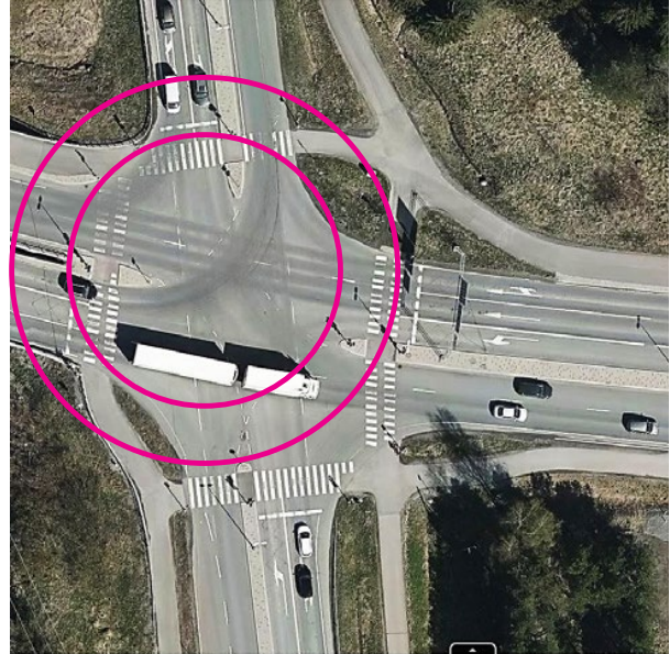
Tuleva kiertoliittymä, Keravantien ja vanhan Lahdentien risteyksessä.
