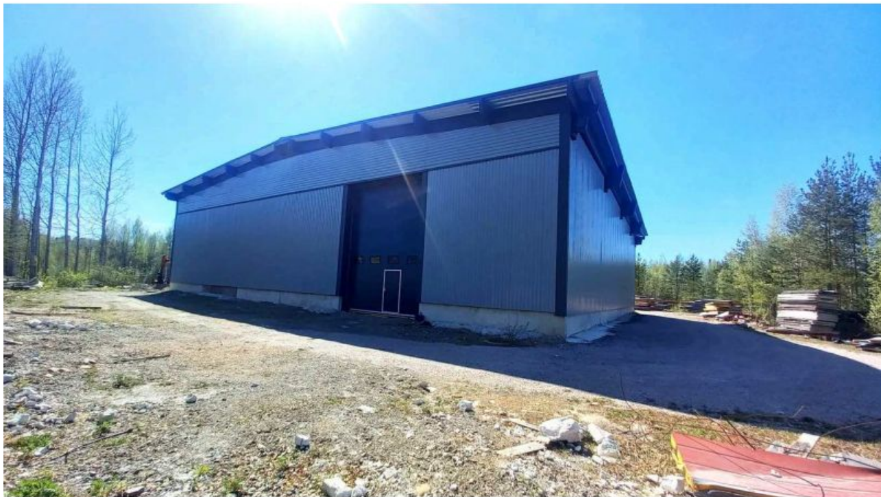
Sammontien puoleinen pääty ja nosto-ovi
